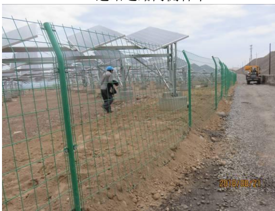
光伏板发电区覆土
