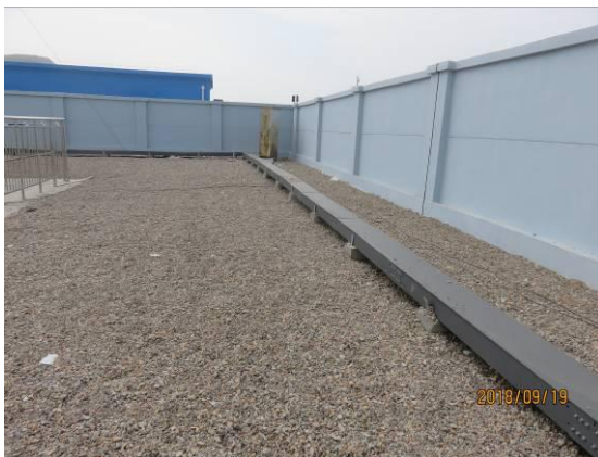
升压站碎石压盖
