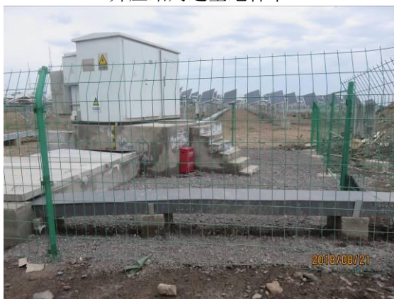
光伏板发电区箱变碎石压盖
