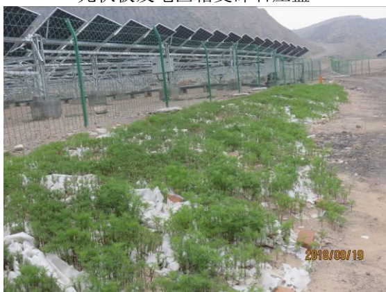
光伏板发电区种草
