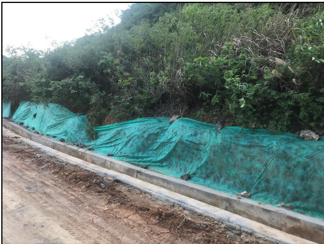
风电场内截排洪沟
