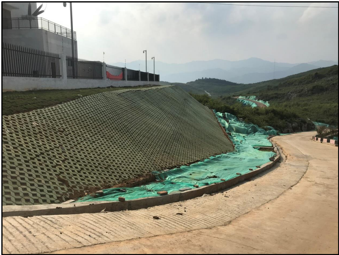
升压站入场道路和边坡护坡情况
