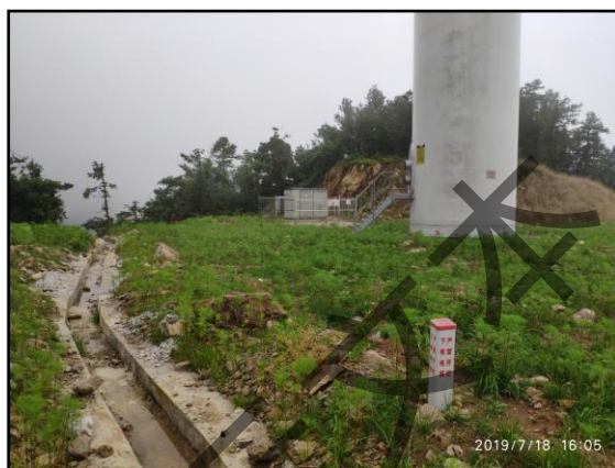
风机平台排水沟
