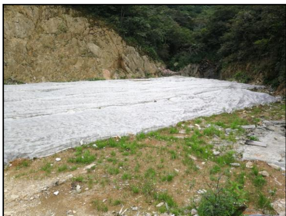
涟源龙山 13#临时施工营地复绿现场照片
