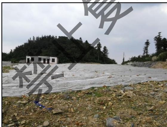
新邵龙山 10#附近临时施工场地复绿现场照片
