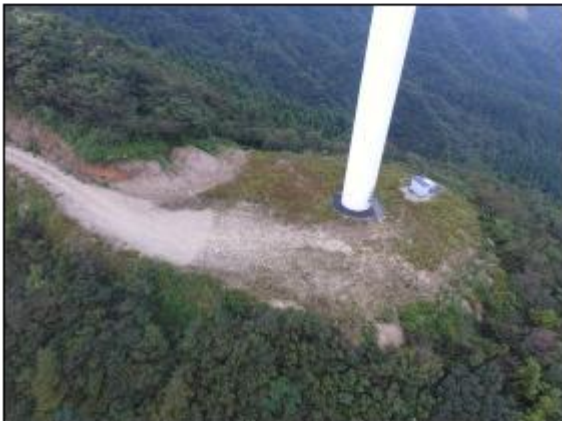
20#风机平台现状
