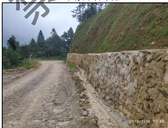
场内道路排水沟、挡墙、绿化
