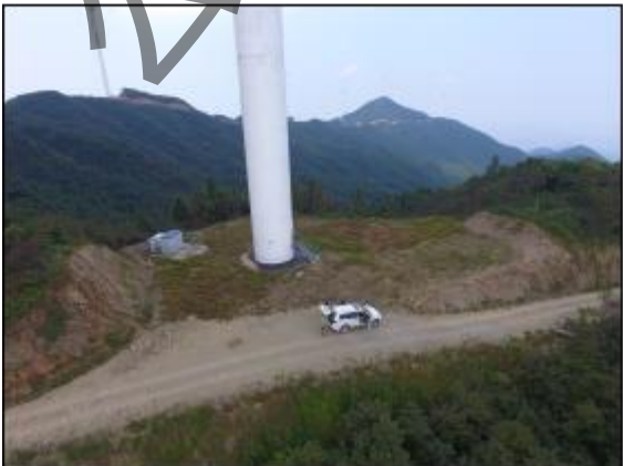
19#风机平台现状
