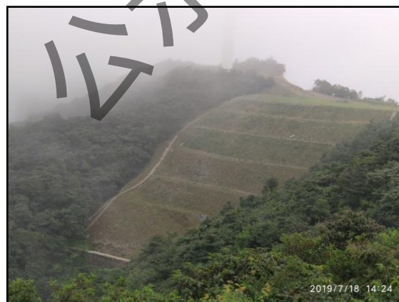
风机平台喷播灌草覆膜绿化
