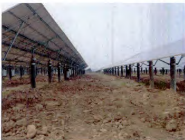
发电工程区建设时 (2017.3)
