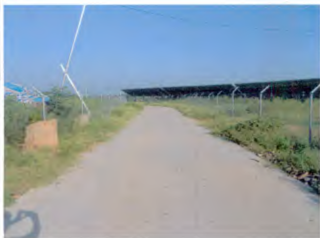
进场道路硬化 (2017.8)
