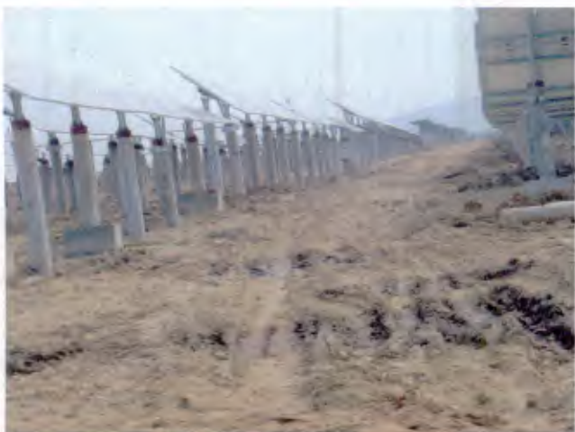
场内施工道路 (2017. 2)
