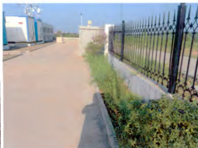
升压站区硬化绿化 (2018.7)
