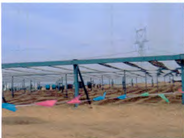
发电工程区建设时 (2016.12)
