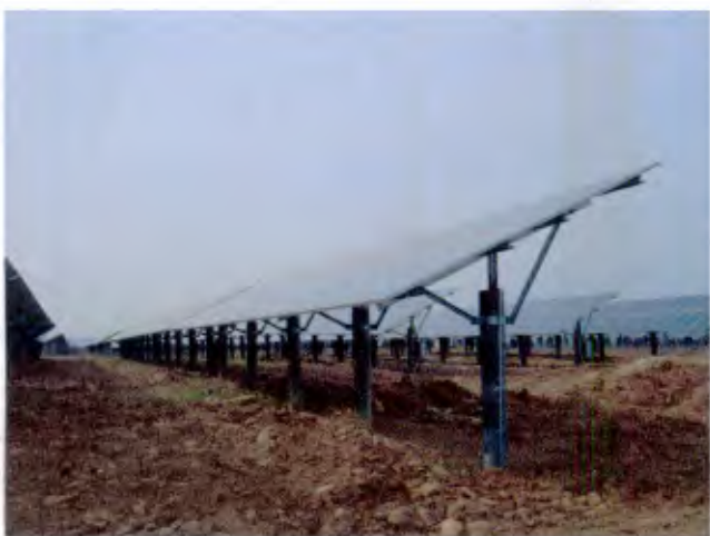
光伏发电区建设时 (2016. 12)
