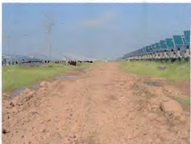
场内施工道路碎石硬化 (2017. 8)
