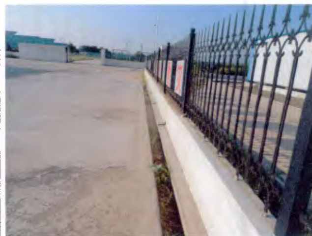
升压站区排水沟 (2017.6)
