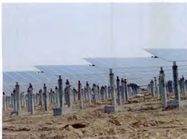
光伏发电区建设时 (2016. 11)
