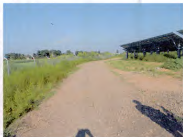
场内施工道路碎石硬化 (2018. 6)
