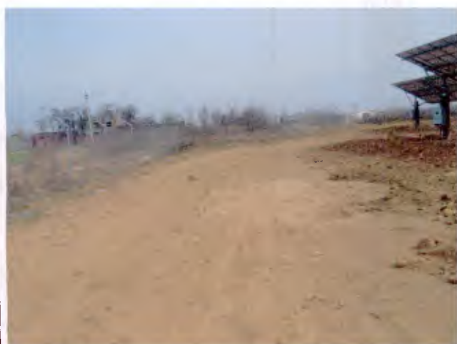
场内施工道路 (2017. 1)
