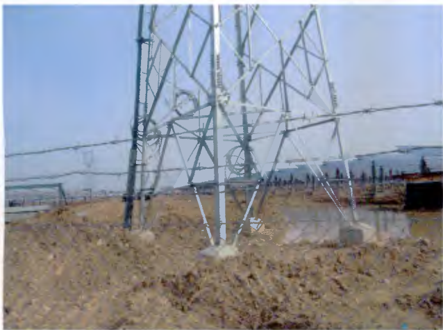
集电线路区建设时 (2017. 4)
