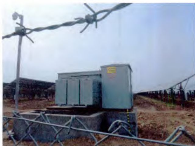
一体化逆变器建设时 (2017.3)
