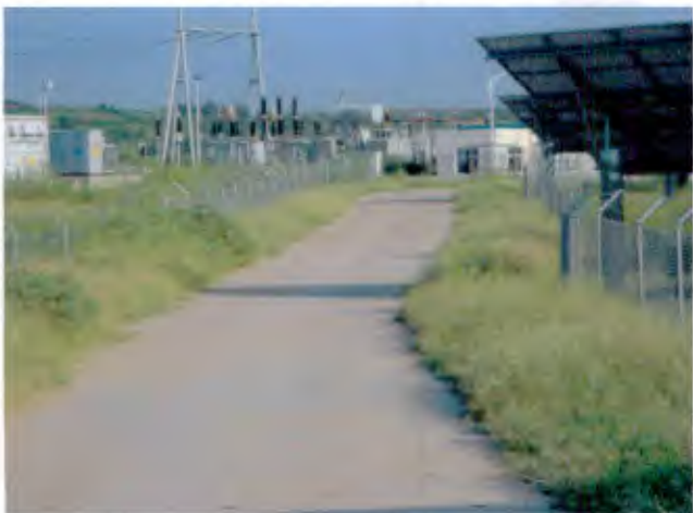
进厂道路硬化 (2018.7)
