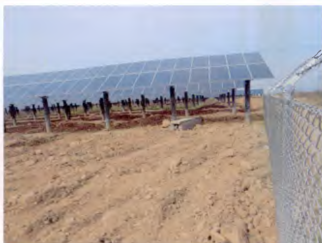
光伏发电区建设时 (2016. 12)
