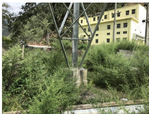
塔基施工区植被恢复后
