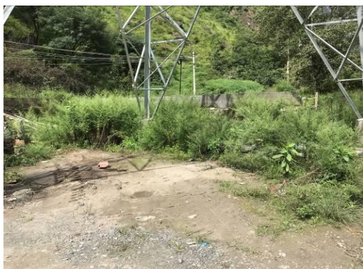
塔基施工区（前）
