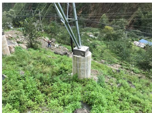
临时施工道路植被恢复后
