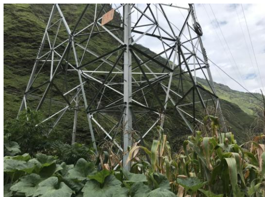
塔基施工区植被恢复后
