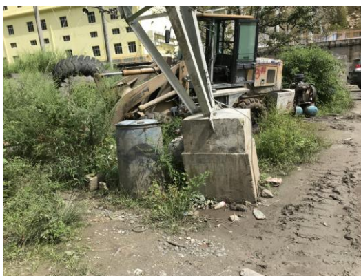
塔基施工区（前）
