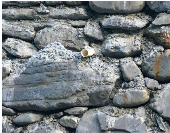
1#渣场挡墙排水孔
