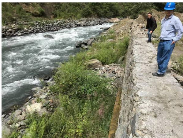
3#渣场临河侧挡墙
