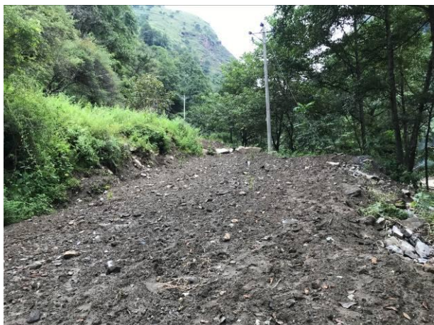
2#支洞施工道路覆土绿化
