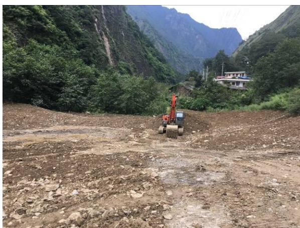
3#渣场覆土过程
