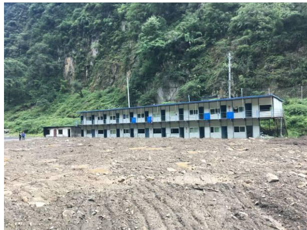
1#施工营地迹地恢复
