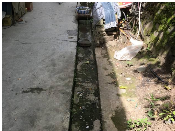
2#支洞口工区排水沟
