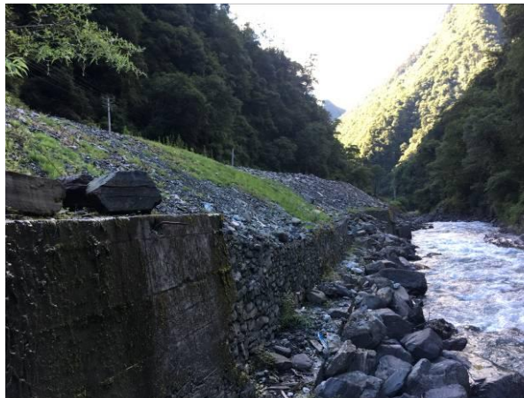
1#渣场临河侧挡墙
