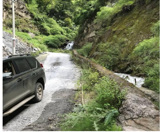
浆砌石排水沟
