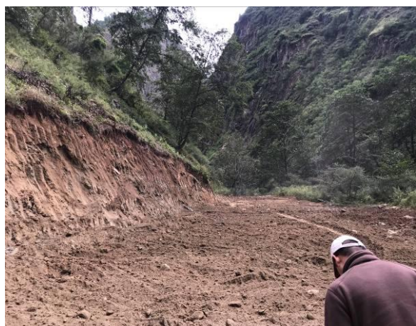
3#支洞施工道路覆土绿化
