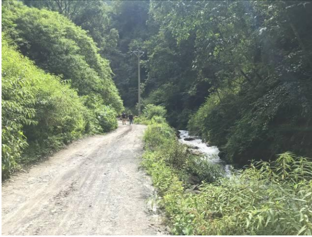
2#支洞施工道路排水沟
