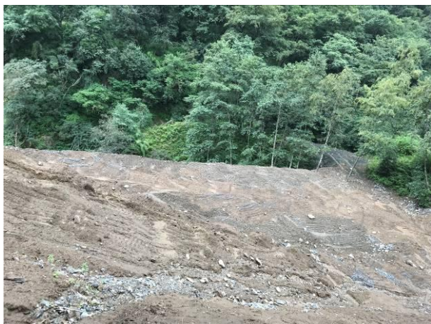
1#支洞施工场地迹地恢复
