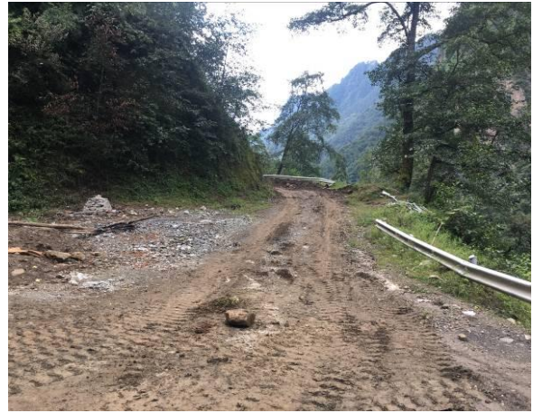
1#支洞口道路土地平整
