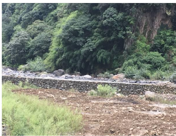
2#渣场下方挡墙
