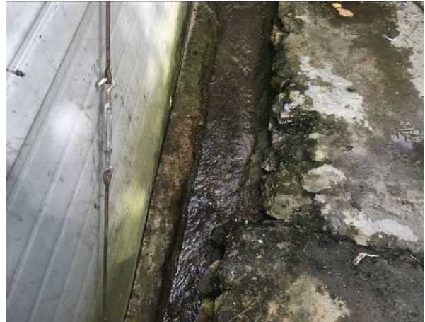
1#支洞口营区排水沟
