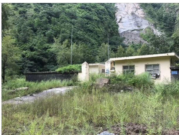
炸药库移交及场地迹地恢复
