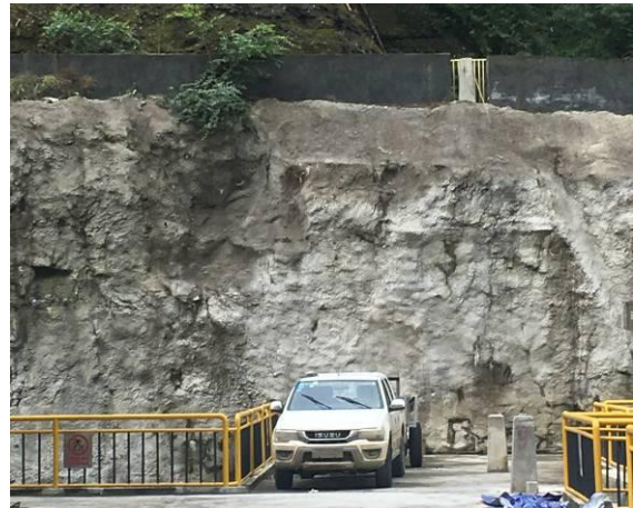
大坝右坝肩护坡及挡墙
