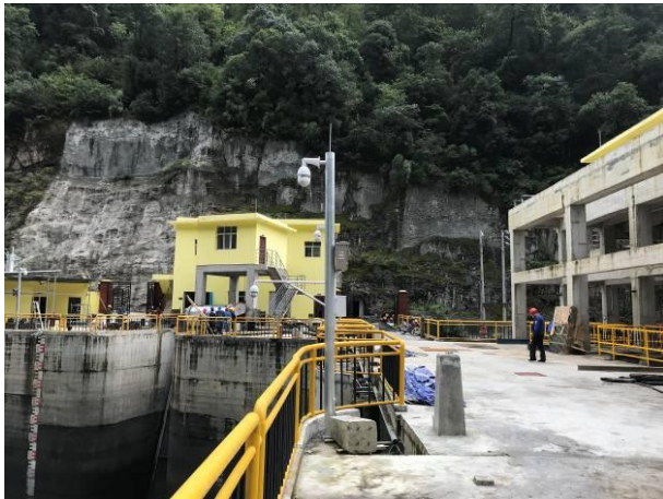
大坝左坝肩挂网砼护坡
