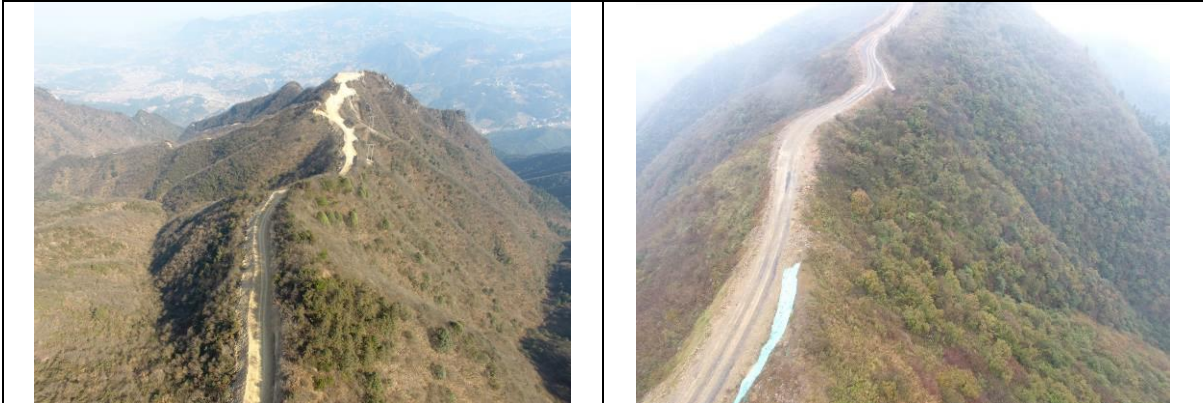
场内道路施工期和完工期对比照片
