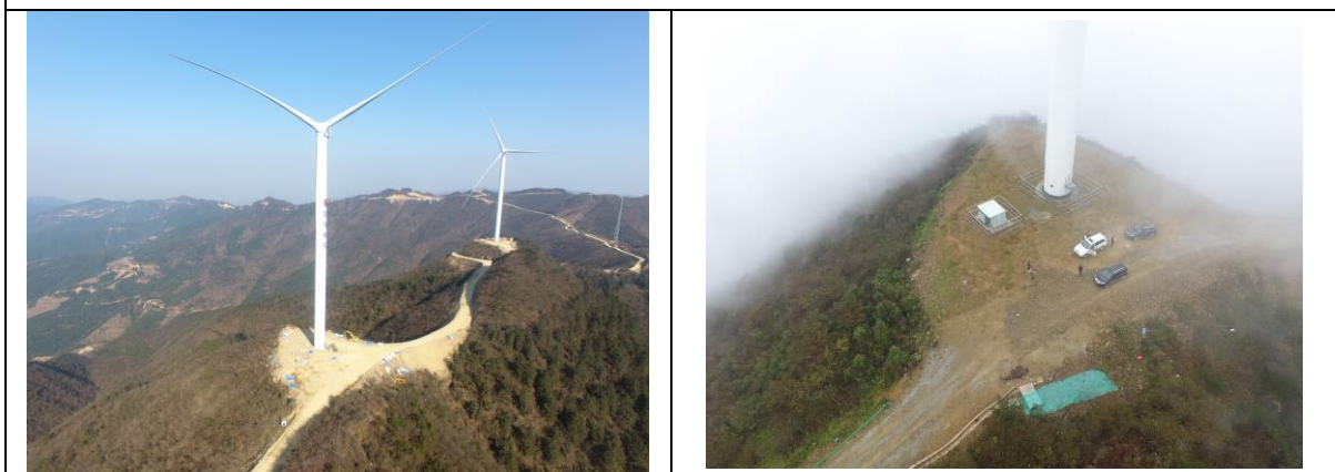
4 号风机施工期和完工期对比照片
