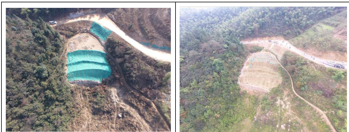
1 号弃渣场施工期和完工期对比照片
