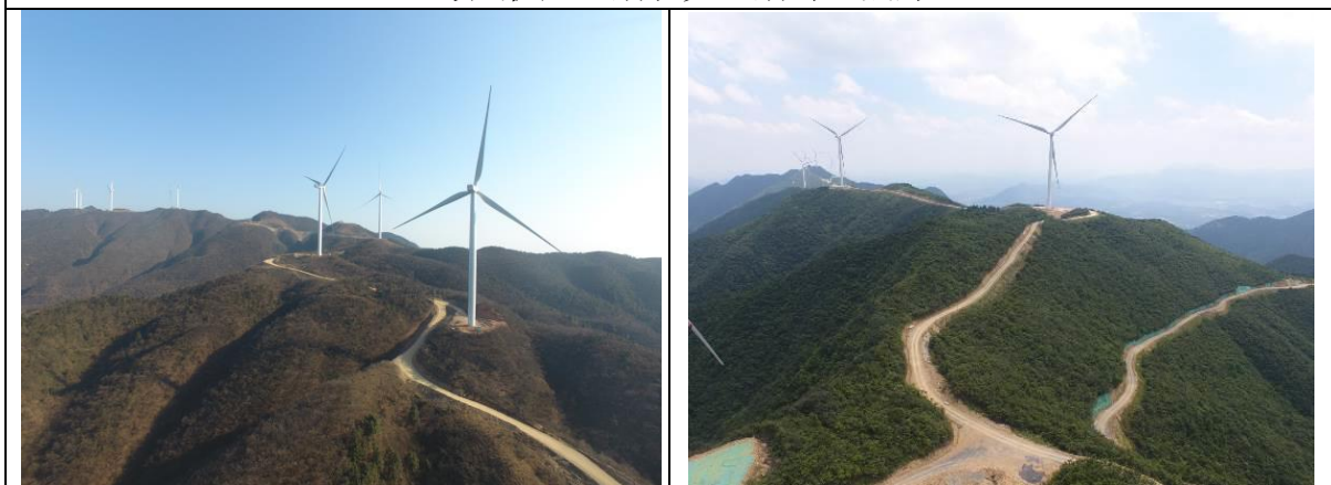
场内道路施工期和完工期对比照片
